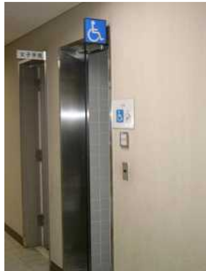
多目的トイレ
