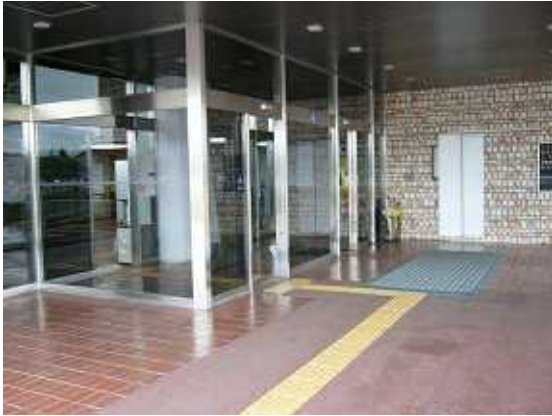
合同庁舎入口 自動ドア
