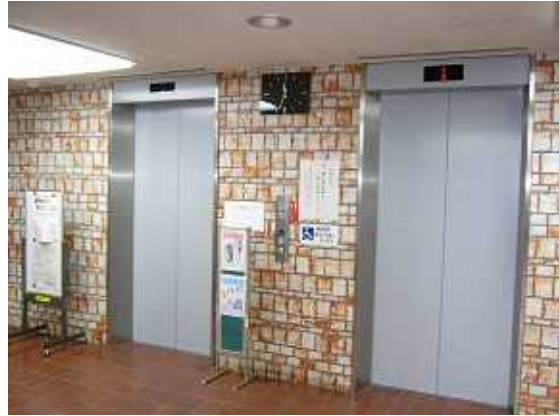
庁舎1階 エレベーター乗降口
