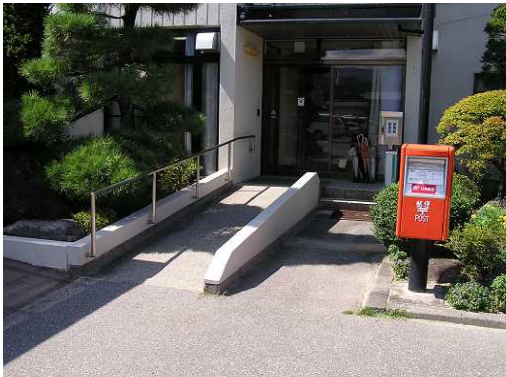
正面玄関北側通用口スロープ
