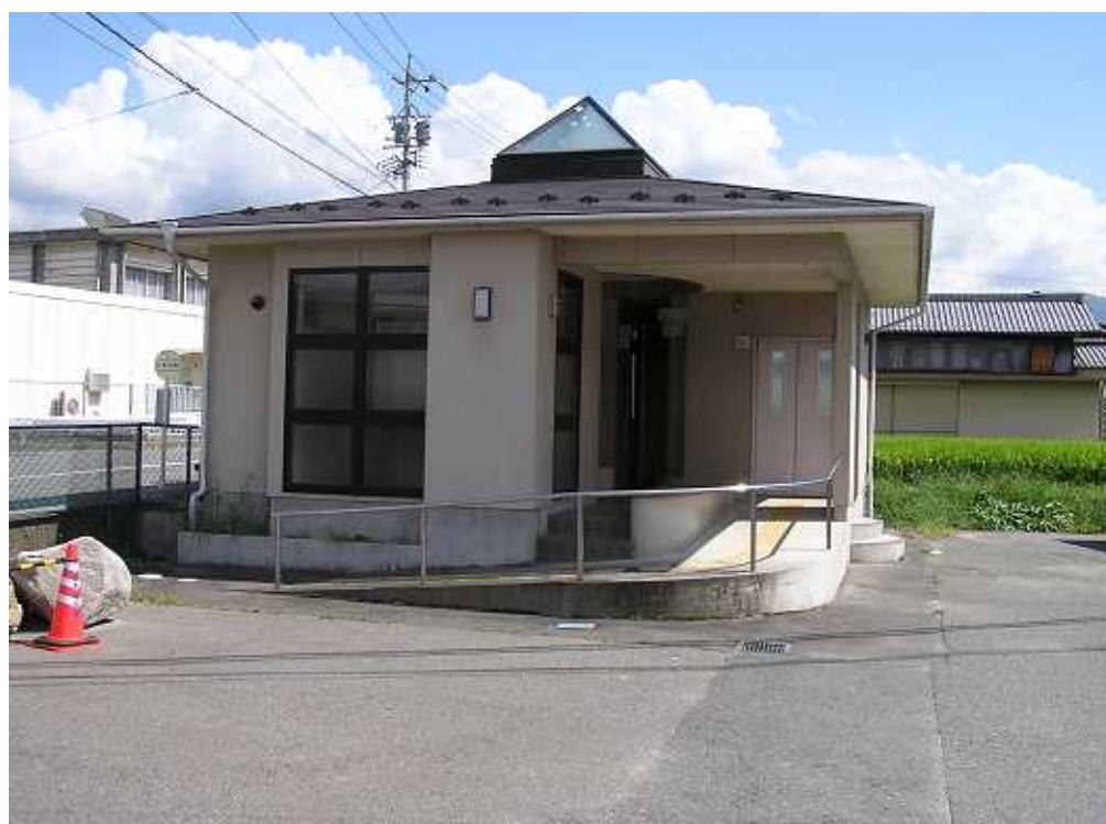
庁舎駐車場内公衆トイレ
