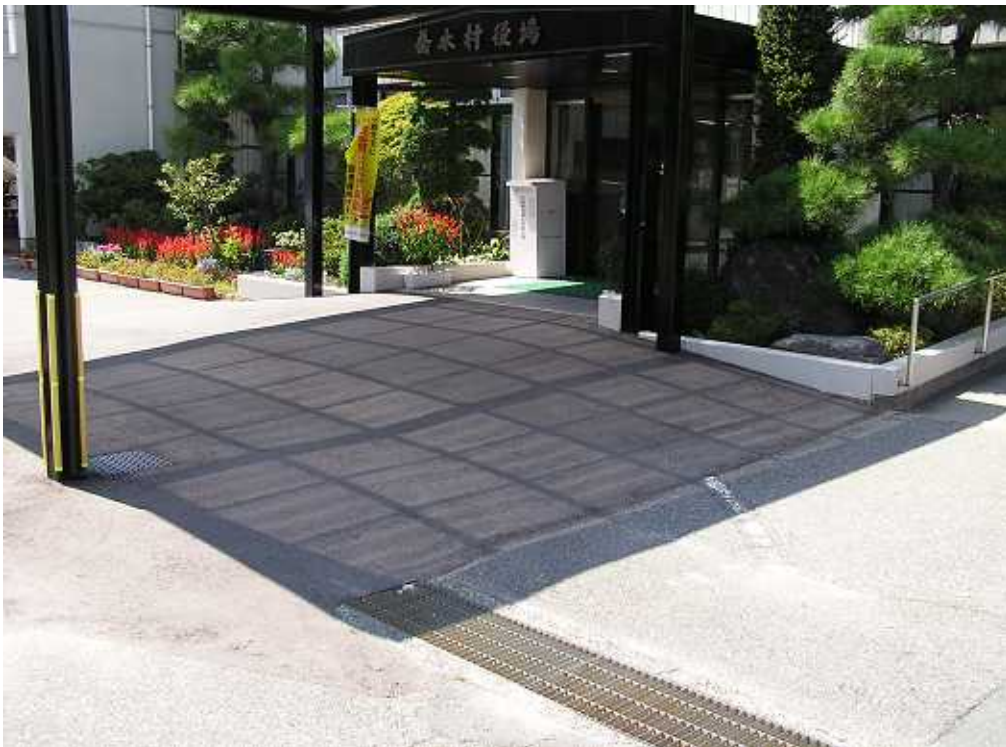
正面玄関スロープ
